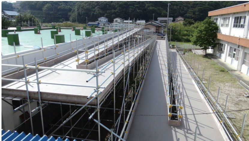
Fig. 2 震災後に設置した病棟屋上への避難用スロープ.
